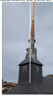
La structure du clocher, supposée construite au XVIIIème siècle est entièrement réalisée en bois. Elle présente actuellement un net dévers qui nécessite des travaux conséquents.
