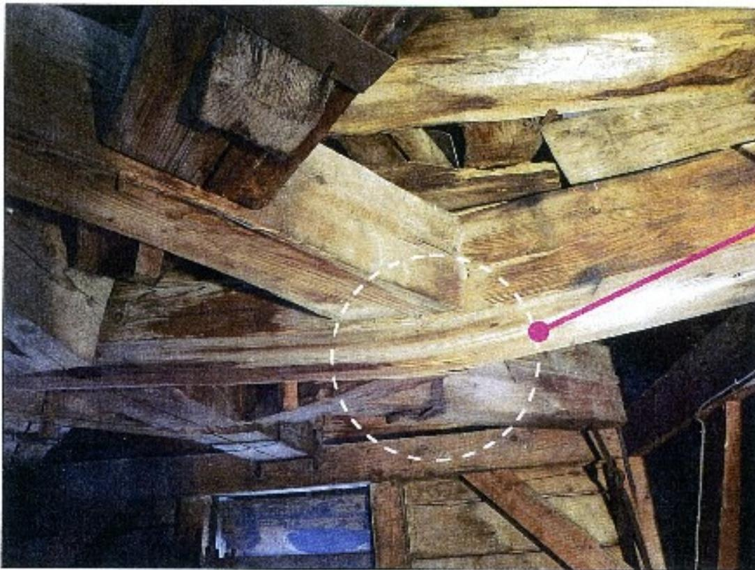
Consolidation du clocher par mise place d'un système d'étau en appui sur la charpente existante pour renforcement de la pièce cassée et reprise de celle-ci
